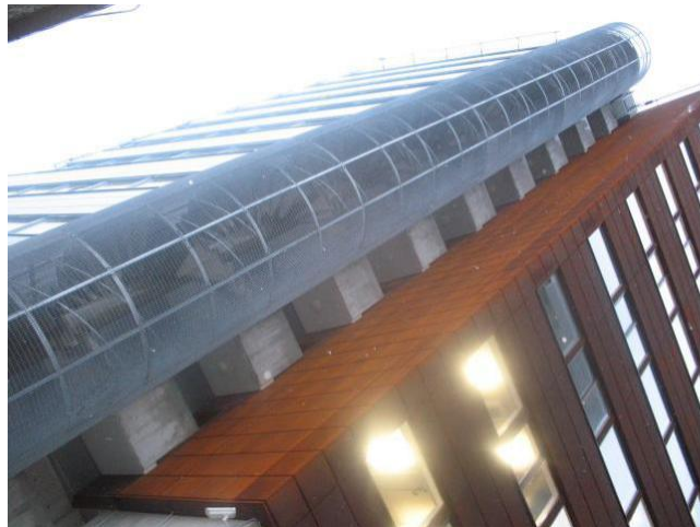
Väline evakuatsiooni trepikoda.
